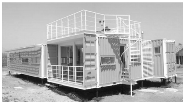
Рис. 7. Мобильный люксовый дом из современных контейнеров на винтовых сваях Ø89/108 с обвязкой из швеллера, бруса/только на сваях.
